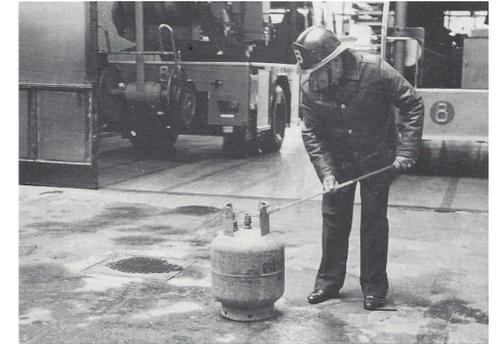
¿Cómo se usa esta herramienta? Para desconectar el regulador, los bomberos apoyan el Simón 8 en una de las orejas del balón de gas, para así tener la posibilidad de generar el torque necesario que les permitirá sacar el regulador de gas de forma segura.
