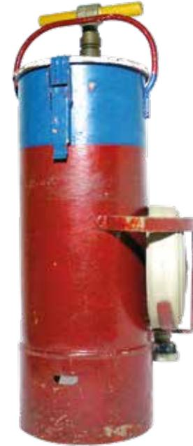
una bomba de cuatro cilindros cargados con una solución de cal y potasa, que al ser operada se generaba la presión necesaria para expulsar el agente extintor en dirección al fuego.
